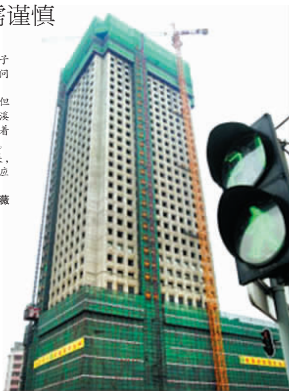
楼市东风让前期无人问津的“烂尾楼”咸鱼翻身
